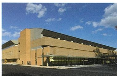
▲ 前橋・前橋市総合福祉会館
