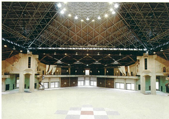
国立京都国際会館 イベントホール
