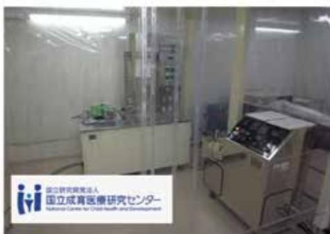
GMPエリア(クリーンブース)内に設置された流動層装置、攪拌造粒装置 [国立成育医療研究センター 戸澤一英様よりデータ提供]
